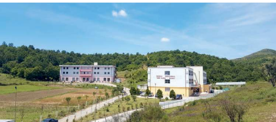
La Scuola Professionale Agricola "Ndre Mjeda" di Bushat: edificio scolastico e alloggi per gli studenti
